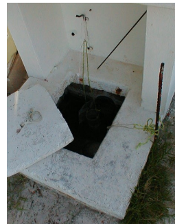
Pozo profundo: no hay tratamiento; el agua contaminada flota por la diferencia de densidades.
